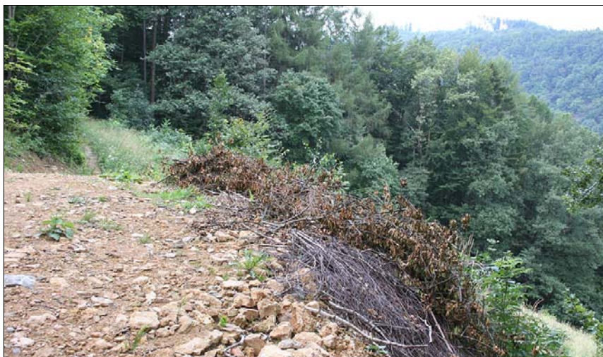
Eine Kehre der neu angelegten Forststraße am Nordhang des Plabutsch liegt direkt auf einem von zwei Fundpunkten der äußerst seltenen Duft-Becherglocke. Fotos: K. Zernig.
