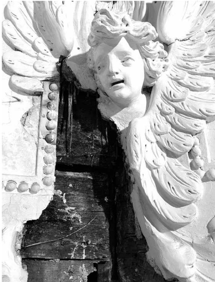
Vor einer sicheren Wiederanbringung musste vor allem die statische Sicherheit der Kuppelschale gewährleistet werden. Dafür wurden alle verrotteten Holzelemente ausgetauscht und neu befestigt sowie eine Stahlklammer als Ringanker um den gesamten Kuppelfuß gelegt, der die Last der Kuppel aufnimmt und die Verschiebung nach außen stoppt. Natürlich wurde auch die schadhafte Verblechung saniert, um weitere Wasserschäden zu vermeiden. (Fa. Holzbau LEITNER)
