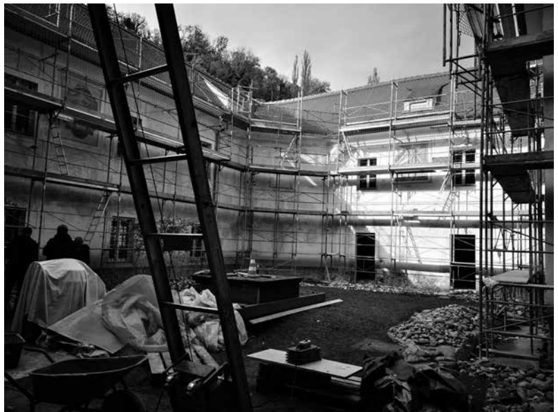
Umbaumaßnahmen im Innenhof des Volkskunde- museums. Foto: UMJ
