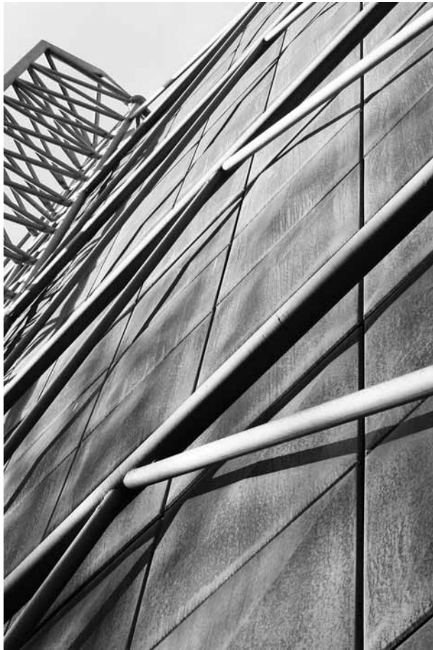
Hubert Hoffmann und Ignaz Gallowitsch (Planer), Hochspannungshalle der Fakultät für Elektrotechnik, TU-Graz, Inffeldgasse (Ausschnitt), Fertigstellung 1972, Foto: UMJ
