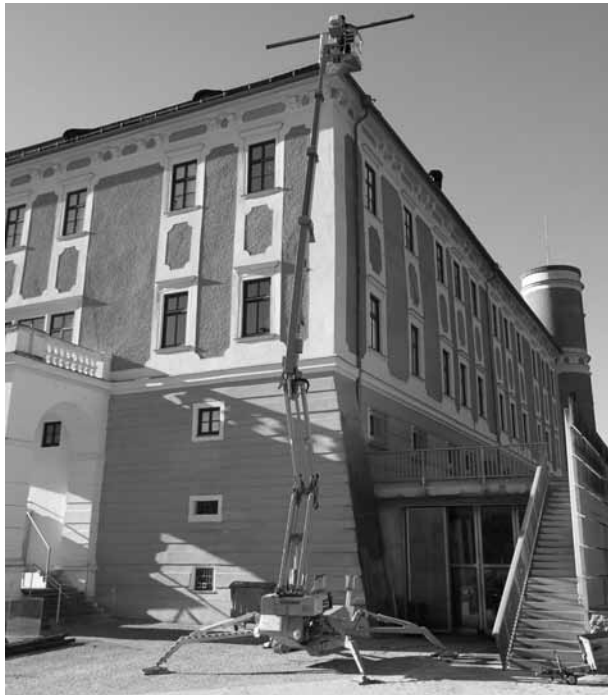
Dachsanierung, Erneuerung der Schneefänger, Foto: K. Krenn
