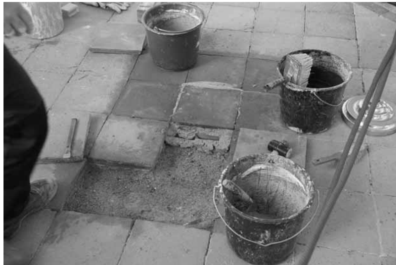
Tausch der beschädigten Ziegelplatten durch detailgetreue Kopien des barocken Originals im Gang des zweiten Stocks, Foto: UMJ
