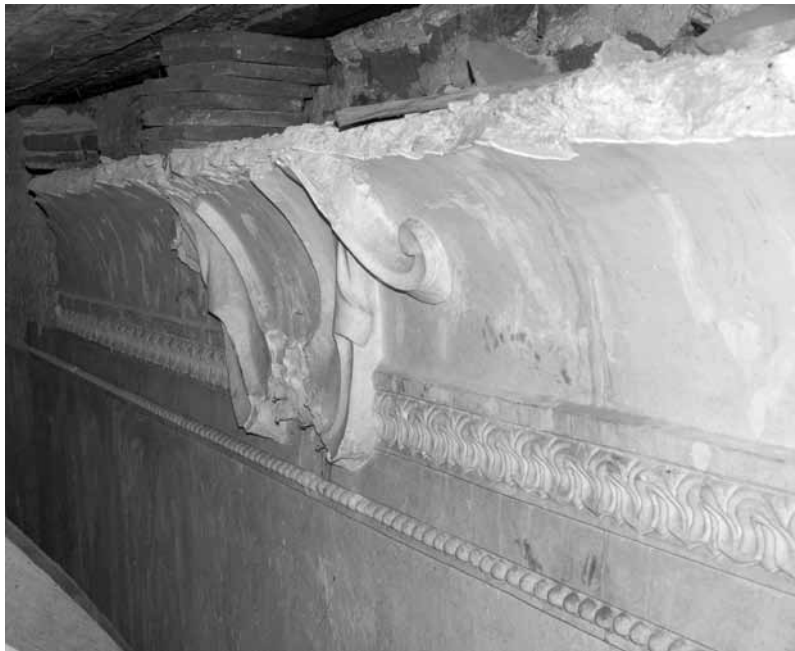
Fragmente der barocken Stuckdekoration des ehemaligen Ballhauses/Theatersaals unter der Decke des heutigen Kirchenraumes. Foto: UMJ/P. Schuster
