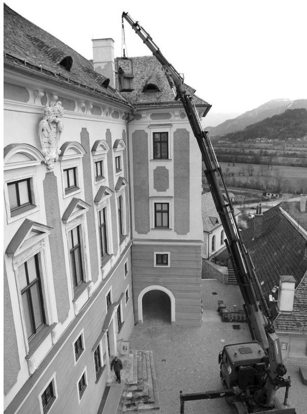
Sanierung des Kamins von Schloss Trautenfels Foto: UMJ / K. Krenn
