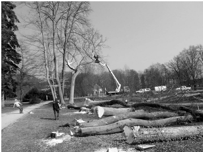
Rodungsarbeiten, Foto: UMJ / P. Schuster
