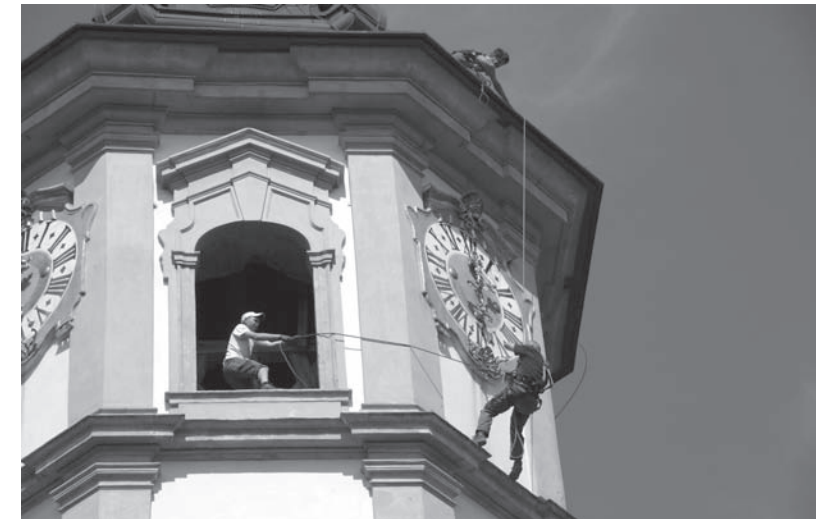
Montage der restaurierten Turmuhrzeiger in 35 m Höhe, Foto: UMJ
