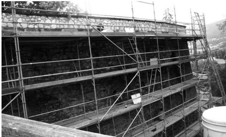
Baubeginn, Gerüst an der Südwest-Bastei, 20.7., Foto: UMJ, K. Krenn
