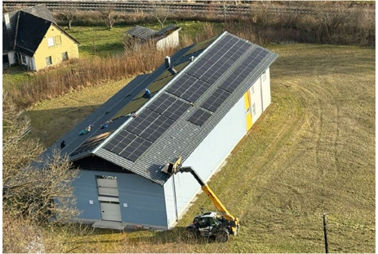
Errichtung der PV-Anlage am Magazin, 19.11., Foto: UMJ/K. Krenn
