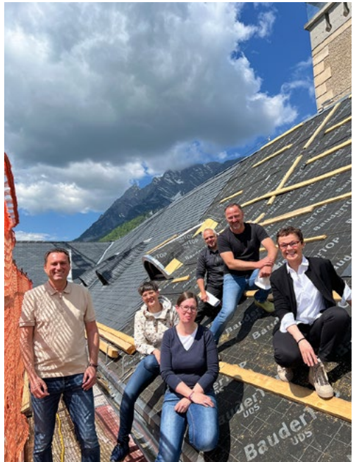
Besichtigung der Dachdeckung, 13.05: Josef Schrammel (UMJ), Elisabeth Seuschek (BDA), Eva Thier (Restaurierung Schwarz), Michael Huber (Schloss Trautenfels/UMJ), Thomas Baumegger (BAU-TECH), Katharina Krenn (Schloss Trautenfels/UMJ), Foto: Christian Schweiger (BAU-TECH)
