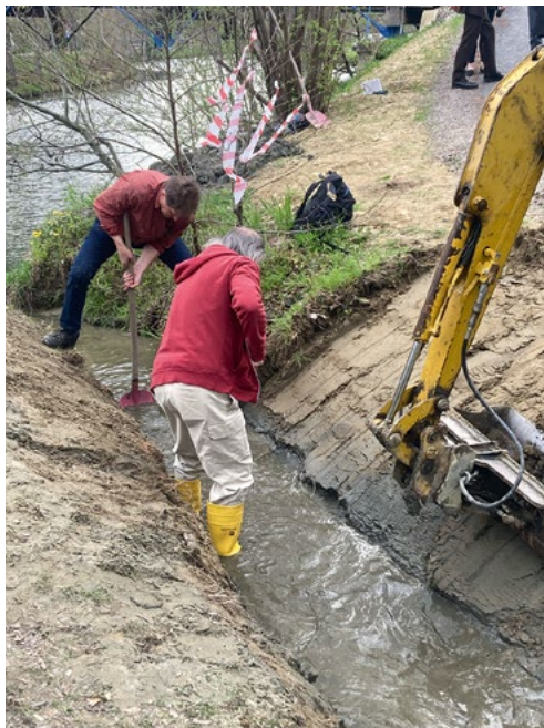
Franzkanalfreilegung am 05.04.2025 © Foto: Andreas Lichtblau
