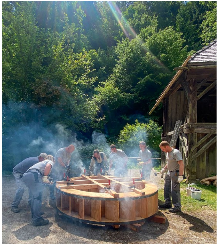
Aufziehen des glühenden Eisenreifens auf das neu gezimmerte Wasserrad.
