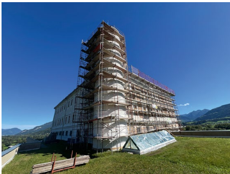
Gerüst am runden Turm und an der Westseite, 15.09., Foto: UMJ/K. Krenn
