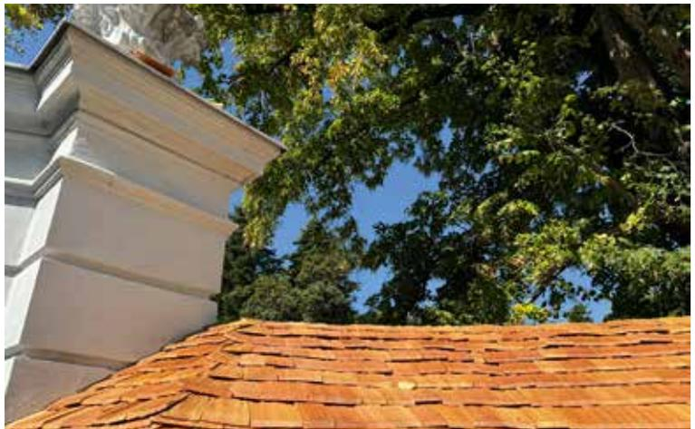
Sanierung der Parkmauer entlang der Schlosstraße. Die Deckung der Mauerkrone erfolgte in diesem Abschnitt mit Lärchenziegeln.
