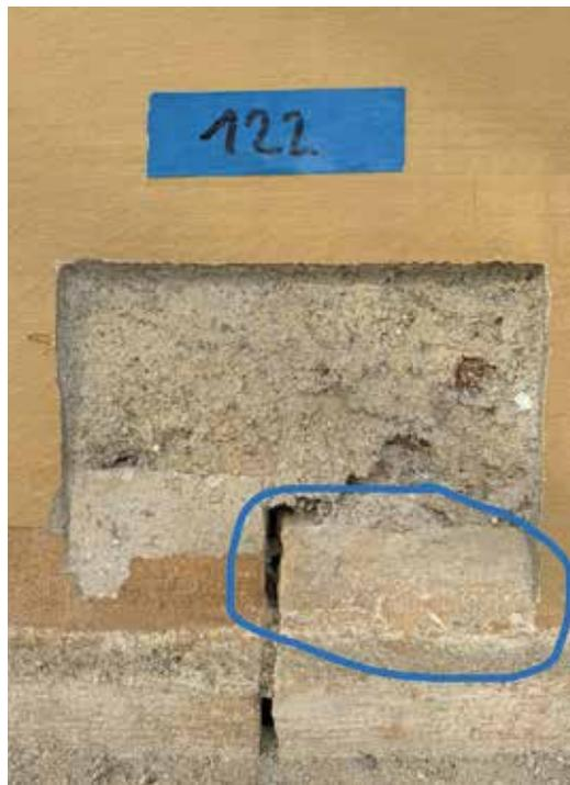
Freilegung und Dokumentation der Fassaden-Erstfassung (Ockerschlämme der Steinteile) unter der rezenten Putzschicht (Erdgeschoß, südlicher Eckturm, Pilastersockel, Plinthenoberkante).
